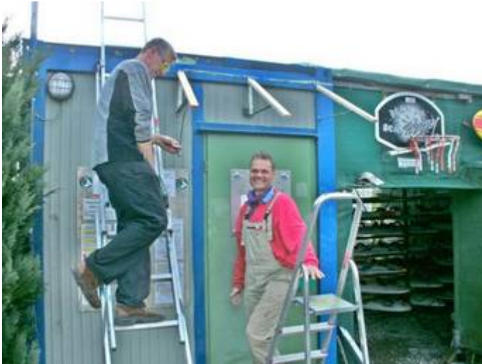
Ein neues Vordach von Torsten und Peter
