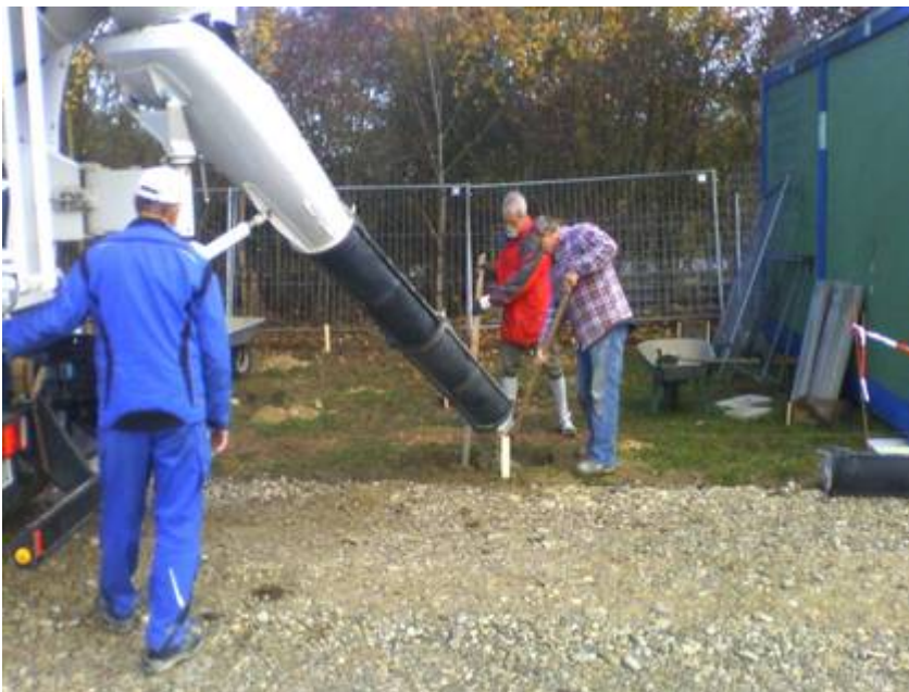
Bernd und Eckehard füllen den Beton ein
