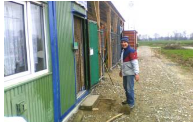
Helmut baut provisorische Treppen zu den Containern
