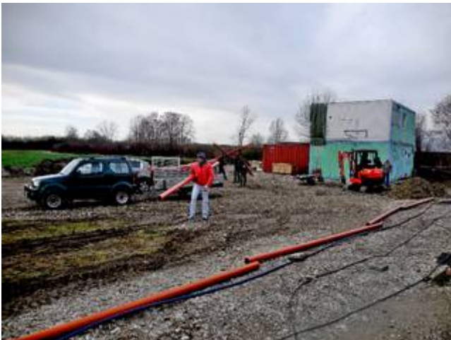
Auslegen der Abwasserrohre: Philipp
