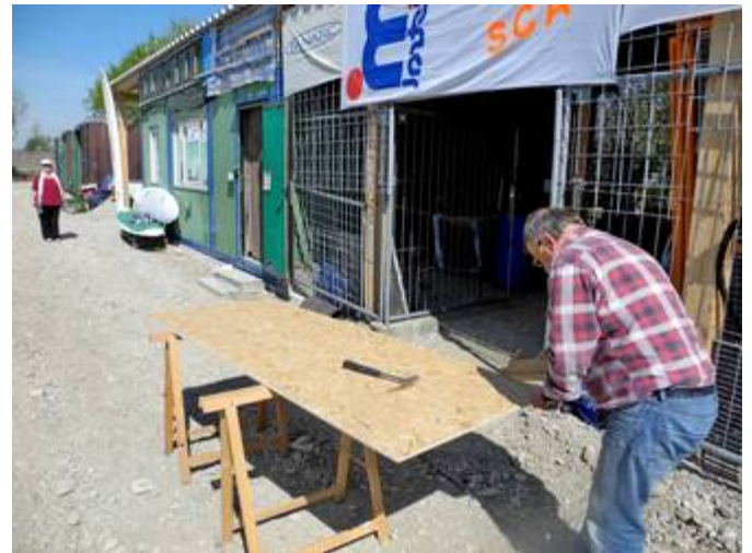
Eckehard bearbeitet eine neue Bodenplatte
