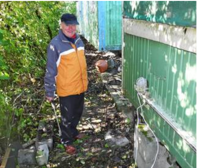
Otto arbeitet an der Hauptstromleitung
