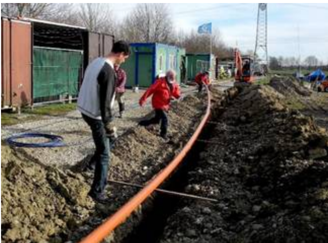
Auslegen der Rohre: Jürgen Alf (KSC)
