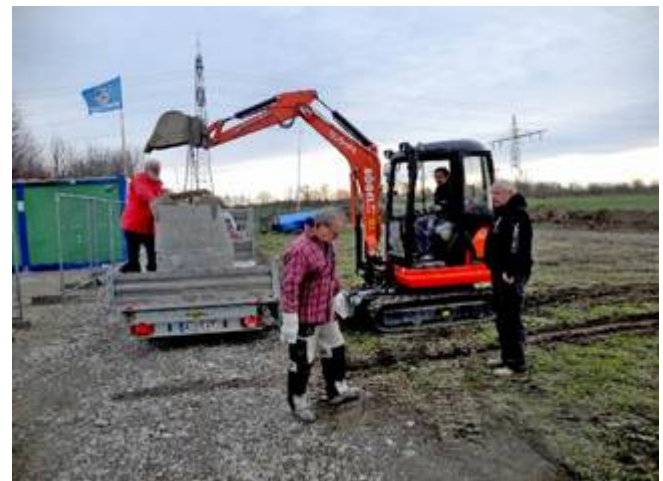
SCA-Versorgungsschacht: Alf Eckehard Erwin (KSC)
