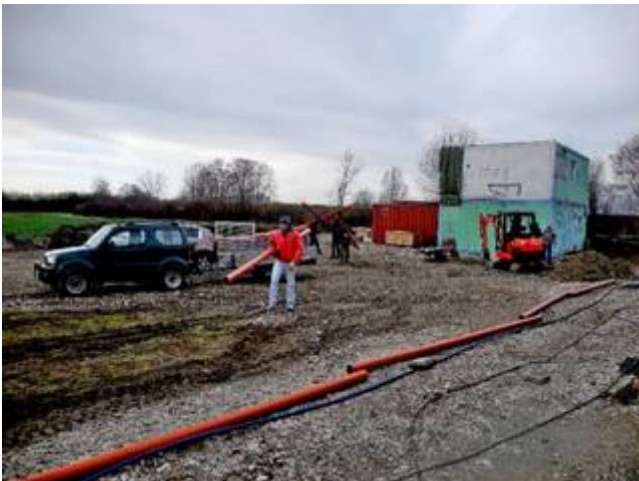
Auslegen der Abwasserrohre: Philipp
