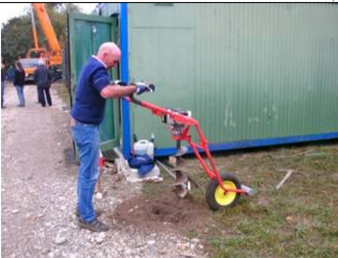
Hier werden die Fundamentlöcher für das Surfständerdach gebohrt
