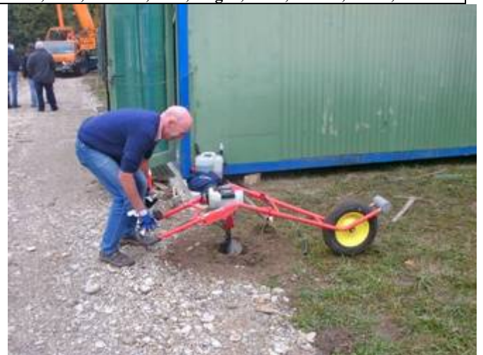
Hier werden die Fundamentlöcher für das Surfständerdach gebohrt
