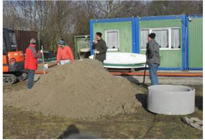
Verteilen des Füllsandes
