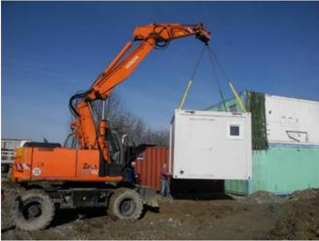
Aufstellen des ersten Sanitärcontainers
