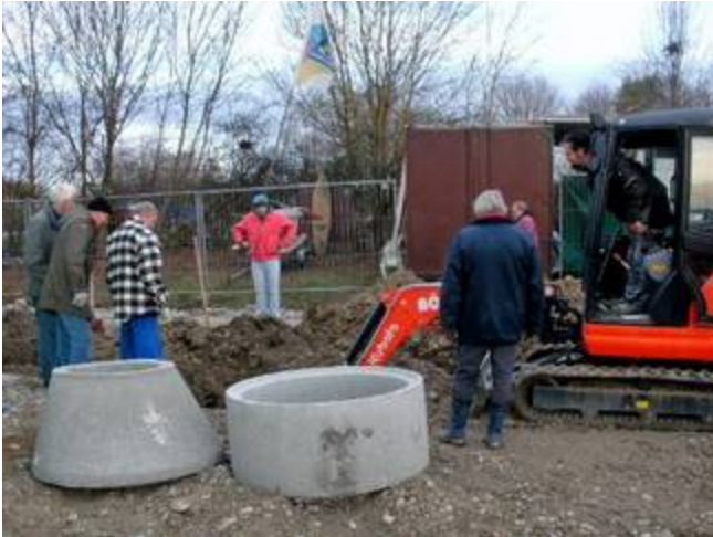
Arbeiten am ersten Versorgungsschacht
