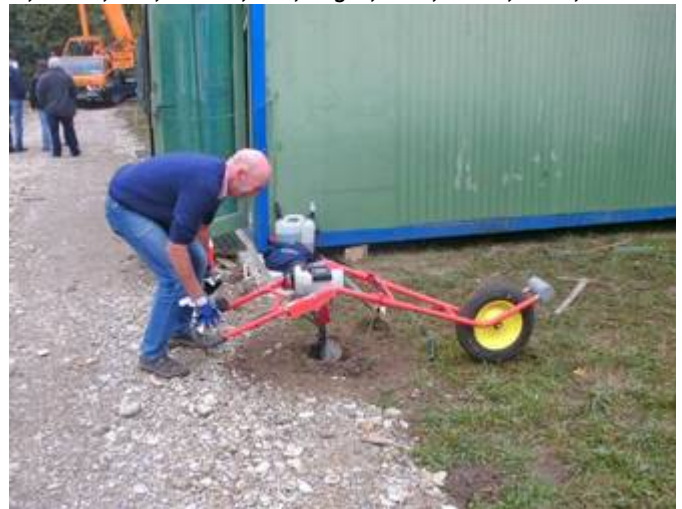
Hier werden die ersten Fundamentlöcher für das Surfständerdach gebohrt
