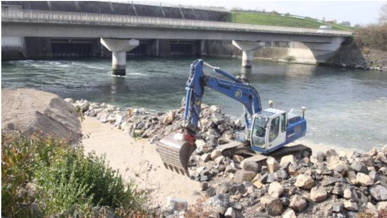
Am östlichen Lechufer unterhalb der Staustufe 23 haben die Arbeiten für eine Fischtreppe begonnen. Foto: Hermann Schmid
