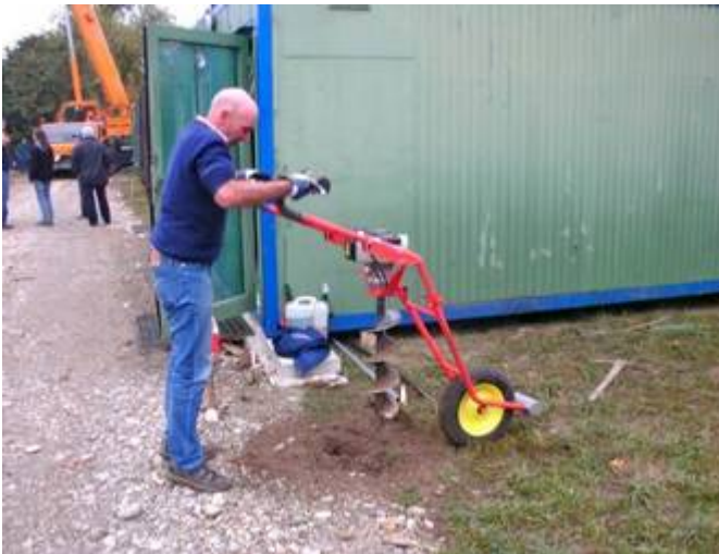
Hier werden die ersten Fundamentlöcher für das Surfständerdach gebohrt
