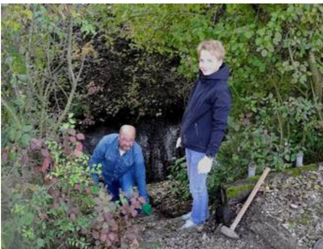
Alwin und Leonard retten die Platten der Bachtreppe.....
