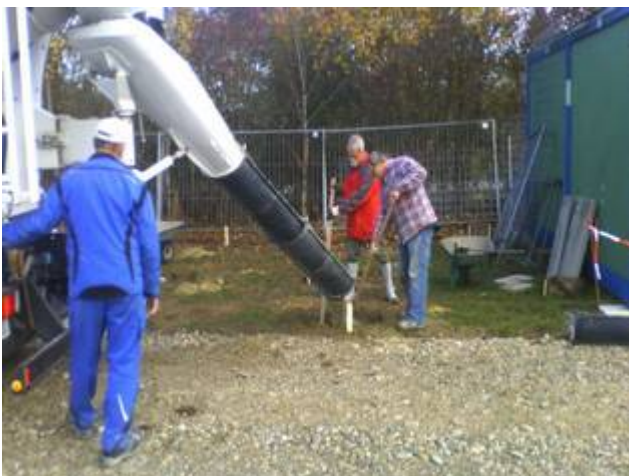
Bernd und Eckehard füllen den Beton ein
