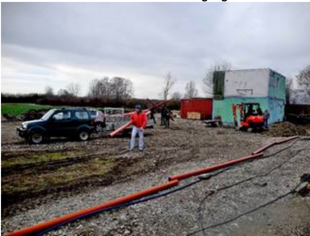
Auslegen der Abwasserrohre: Philipp
