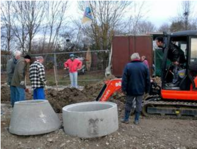
Arbeiten am ersten Versorgungsschacht
