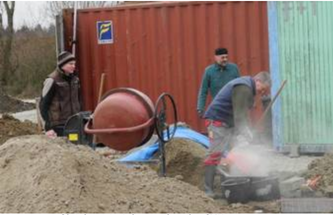
Gleichzeitig Arbeiten bei der SVM
