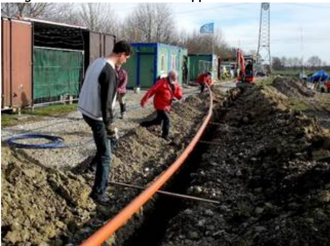
Auslegen der Rohre: Jürgen Alf (KSC)
