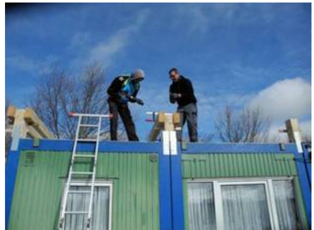
verschrauben die Dachbalken (Zangen)
