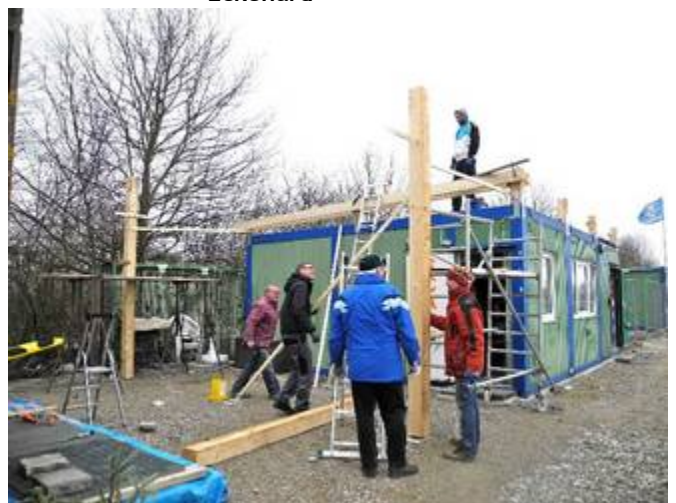
Dachgerüst der Terrasse
